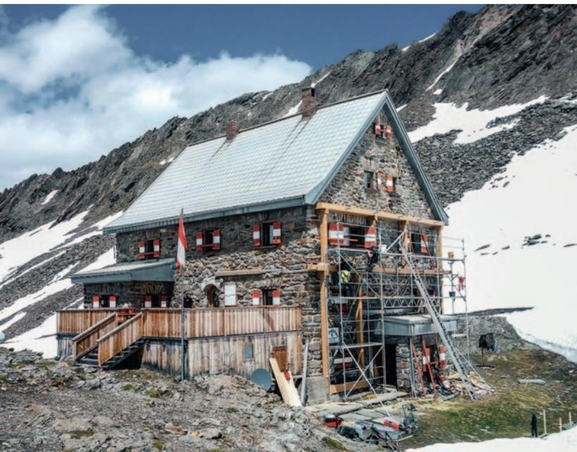
**Das Hochwildehaus muss mit einer massiven Holzkonstruktion gestützt werden. Einem Abriss könnte sie aber entgehen.** Foto: Robert Kolbitsch, DAV
